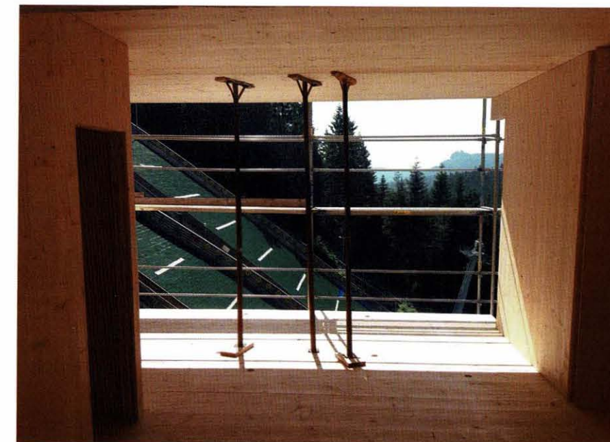
Bild 8: Den Erker formen eine Kragwandscheibe (rechts im Bild) und der unterseitig an sie hochgeschraubte Boden bzw. die aufgelagerte Dachdecke.
