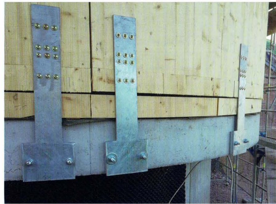
Bild 9: Zuganker verbinden in den ausgerundeten Gebäudeschmalseiten die Wandelemente des Erdgeschosses mit der Stahlbetondecke über dem Sockelgeschoss (Bildquelle: Zimmerei Uwe Quenzel)
