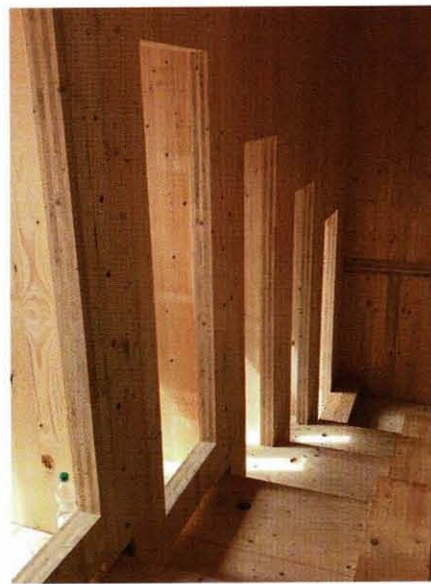
Bild 5-2 und 5-3: Höhenversetztes „Einhängen“ der verschiedenen Ebenen für die Kampfrichter-Kabinen zwischen Außen- und Treppenhauswand (links). Holz-Rohbau mit bereits eingefügten Kabinentrennwänden bzw. Haupt-Trennwand zum Zugangsbereich (rechts). (Bildquelle: SGHG Planungs- und Prüfgesellschaft Bautechnik mbH)
